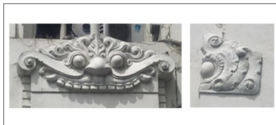
Gambar 5. Ornamen Kala-makara pada fasade (Dokumentasi: Ganesha Wibisana, 2021)
