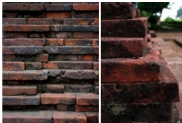
Gambar 5. Bentuk dan detail susunan batu bata (Sumber: Dokumentasi Penulis, 2018)
