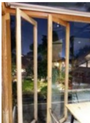
Gambar 15. Bukaan Jendela Lantai 2 (Sumber: Penulis, 2018)
