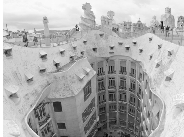
Gambar 9. Bukaan kecil pada bagian tengah gedung
